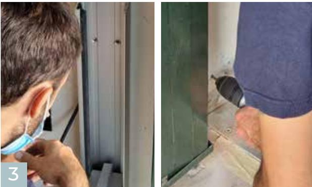
3 Markieren Sie die Position der Aufnahmeprofile und die Löcher für die Dübel. Bohren Sie die Löcher und setzen Sie die Dübel ein.
