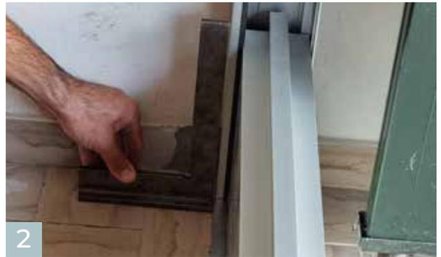
2 Positionieren Sie die Aufnahmeprofile mit einem Anschlagwinkel senkrecht zum Boden.
