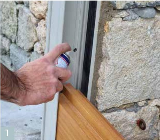
Schmieren Sie die vertikalen Dichtungen großzügig mit Schmiermittel, bevor Sie die Dammbalken einsetzen.
