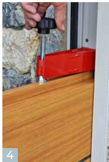
Nach dem Einsetzen aller Module führen Sie die Arretierungen von oben ein und lassen Sie sie bis zum Dammbalken gleiten. Lösen Sie dabei den Drehknopf vollständig.
