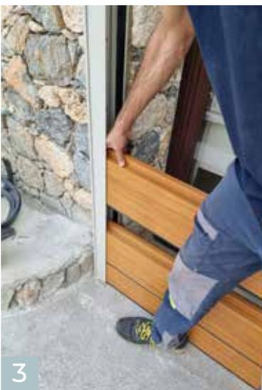
Heben Sie das Ende des Dammbalkens, das zuerst eingeführt wurde, um ein paar Zentimeter an, und positionieren Sie es neu, um die vertikale Dichtung korrekt auszurichten.
