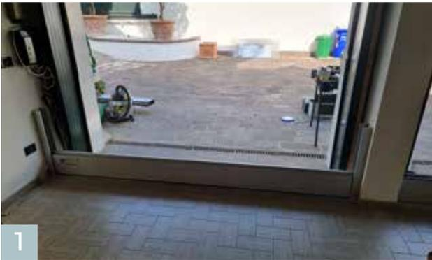
1 Stecken Sie ein Dammbalken-Modul in beide Aufnahmeprofile.
