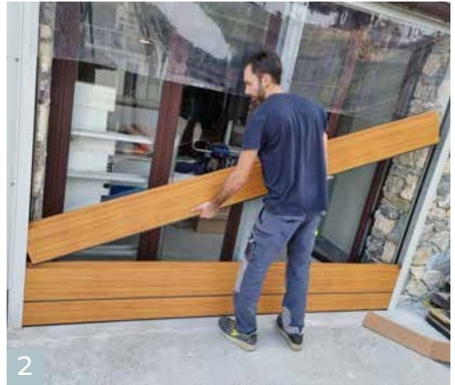
Setzen Sie die einzelnen Dammbalken zunächst auf einer Seite ein, dann auf der anderen, und lassen Sie sie nach unten gleiten.
