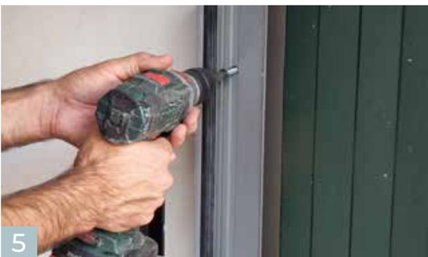
5 Setzen Sie die Aufnahmeprofile zuerst am Boden auf und befestigen Sie sie an der Wand. Bitte die Angaben des Dübelherstellers zum maximalen Drehmoment beachten!
