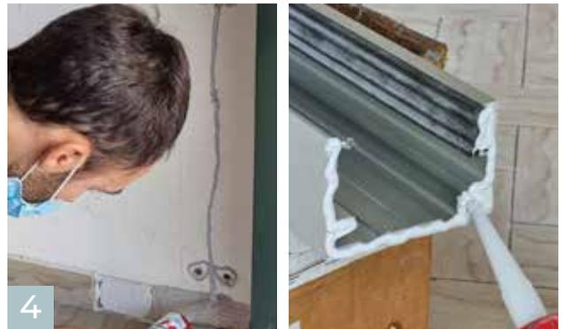
4 Tragen Sie Dichtstoff auf die Wandkontaktflächen und auf die Bodenaufstandsfläche des Aufnahmeprofils auf.
