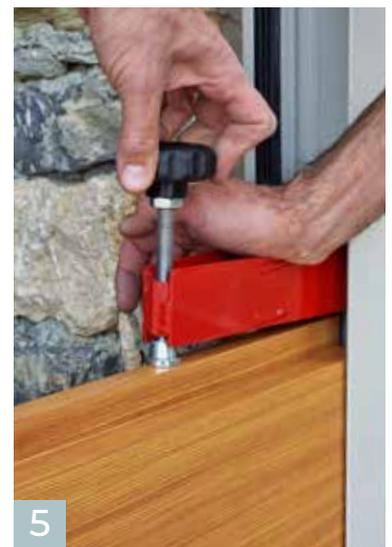
Schrauben Sie die Drehknöpfe fest, während Sie die Enden der Arretierung gegen die Dammbalken drücken. Nach Abschluss des Vorgangs müssen die Arretierungen auf beiden Seiten gleichmäßig angezogen und fixiert sein.
